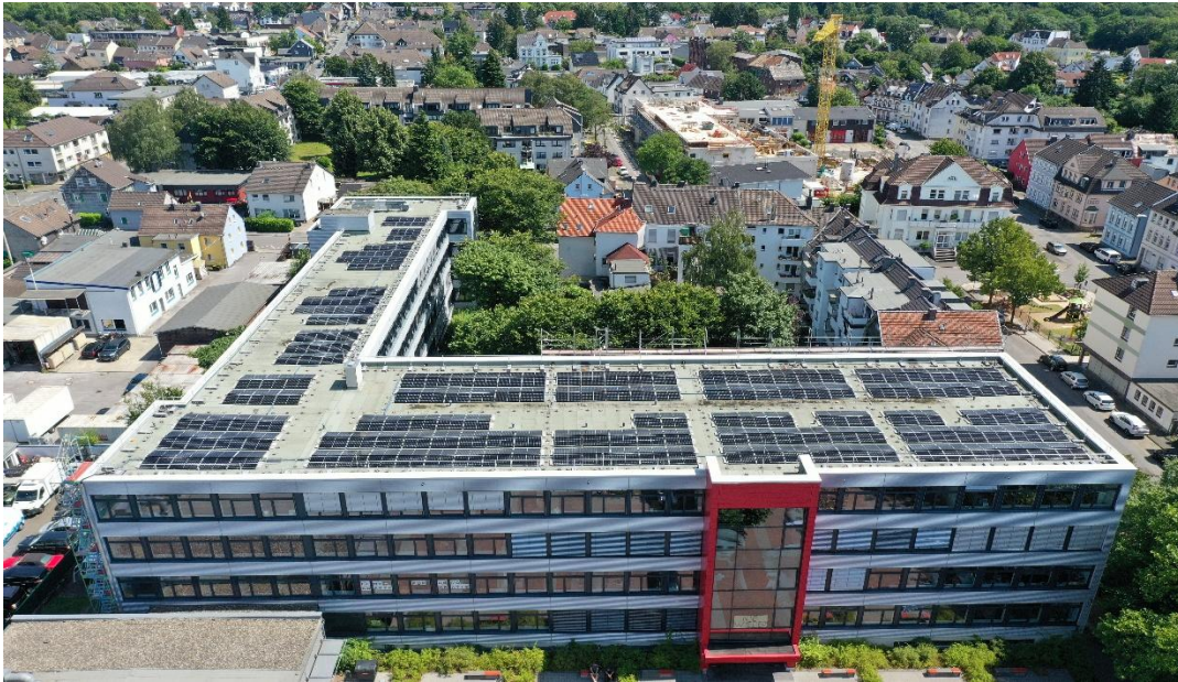
Unsere Anlage auf dem Dach der Geschwister-Scholl-Schule. Foto: Enteria
