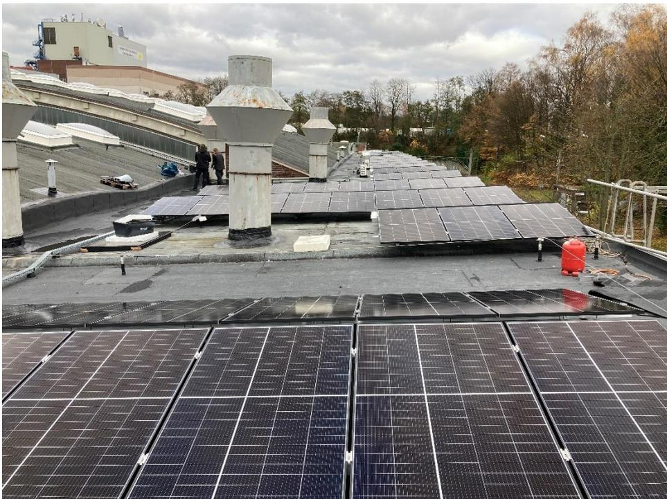
**Fast fertig: Unser neues PV-Kraftwerk an der Weidenstraße auf dem Gelände der Solinger Verkehrsbetriebe mit einer Leistung von 96,6 KW**
